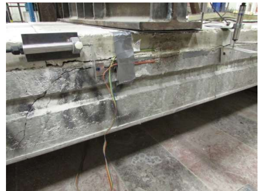
(d) FMB2-2 (flexural shear failure).
